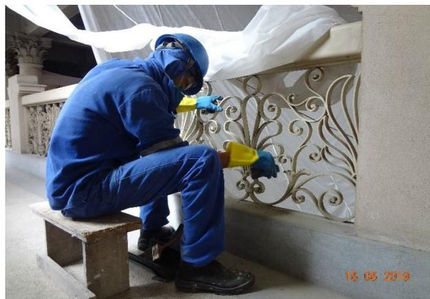
Lixamento das partes metálicas do guarda corpo do mezanino
